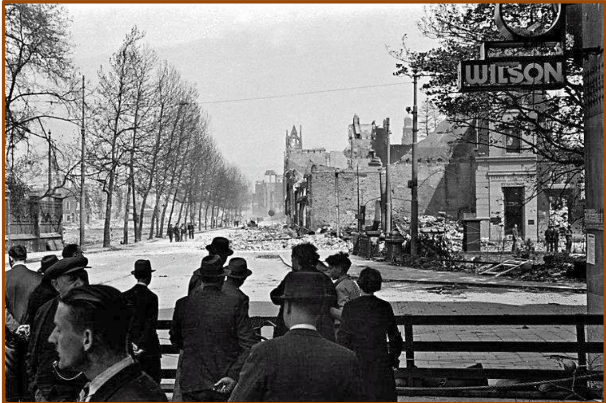
Oorlogsschade na het bombardement van Rotterdam (foto: Ed van Wijk)
